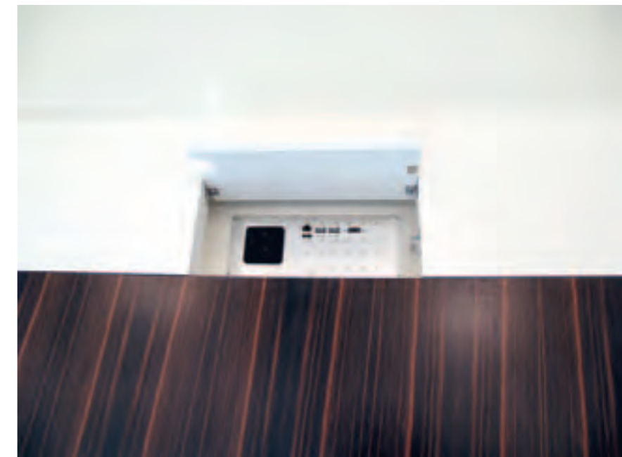
Medientechnik im Mittelfeld - Technikkappen Nr. KT mit Kabeldurchlass.
